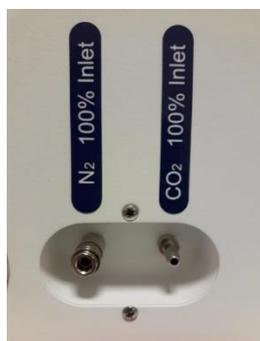
Figura 11.1 Entradas de gás na parte posterior das incubadoras de FIV multicâmara Mini MIRI® Dry e Mini MIRI® Humidity
