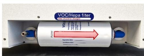
Figura 12.3 Filtro COV/HEPA instalado corretamente
