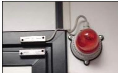
De acordo com a norma IEC 60825-1, todos os dispositivos a laser devem estar equipados com um conector de trava remota, conectado à porta de acesso da sala, prevenindo a emissão do laser quando a porta estiver aberta.
