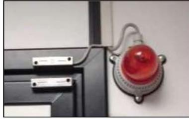
**Fig. 1** Conexão de intertrava remota
